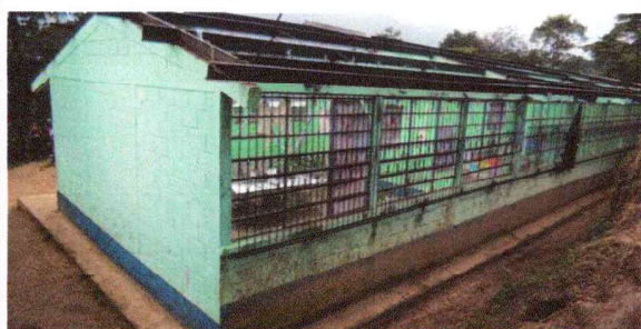
Foto 1: Desinstalación de las láminas de zinc del módulo principal para ser remplazadas por láminas troqueladas calibre 26.
