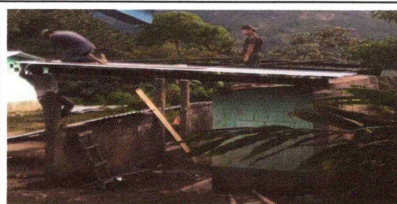
Foto 5: Sustitución de láminas y mantenimiento de puertas en el area de baños
