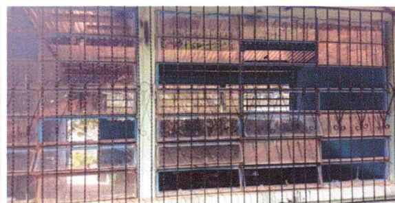
Foto 2: Mantenimiento de ventanas con el retiro de vidrios quebrados para ser sustituidos con vidrios nuevos.
