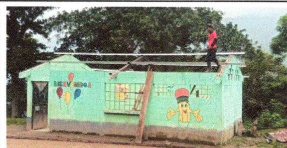
Foto 3: Desinstalación de láminas de zinc del módulo de la cocina y colocación de costaneras de metal.
